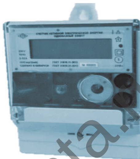
Рис. 3. Счетчик активной электрической энергии однофазный многофункциональный электронный ЭЭ8017, осуществляющий учет электрической энергии по одному, двум, трем или четырем тарифам
